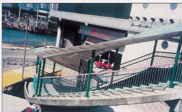
Shun Tak Footbridge Link 信德中心行人天橋上蓋
